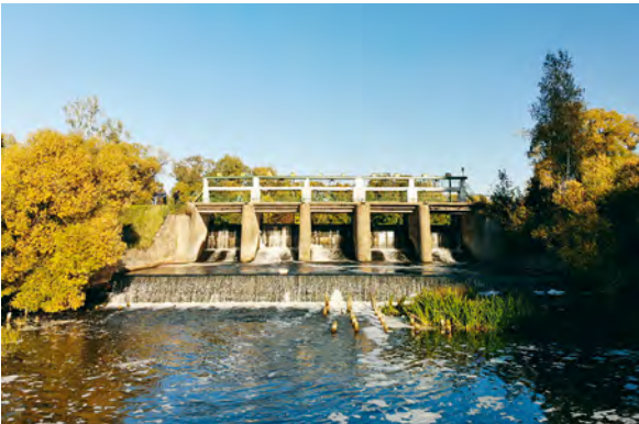
Noch verhindert der Stracha-Damm in Weißrussland im Flusssystem der Memel, dass Lachsartige stromaufwärts zu geeigneten Laichgebieten wandern; eine im Rahmen des Projekts errichtete Fischpassage wird dies jedoch künftig ermöglichen
