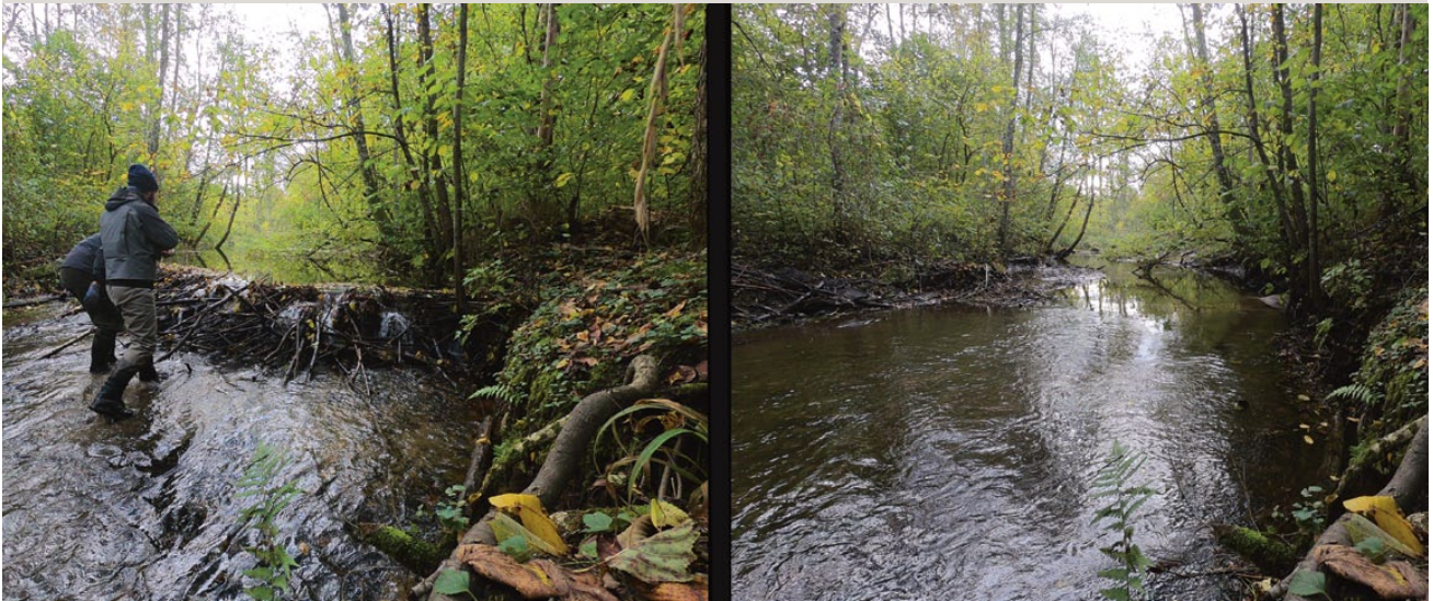
Removal of a beaver dam Beseitigung eines Biberdammes
