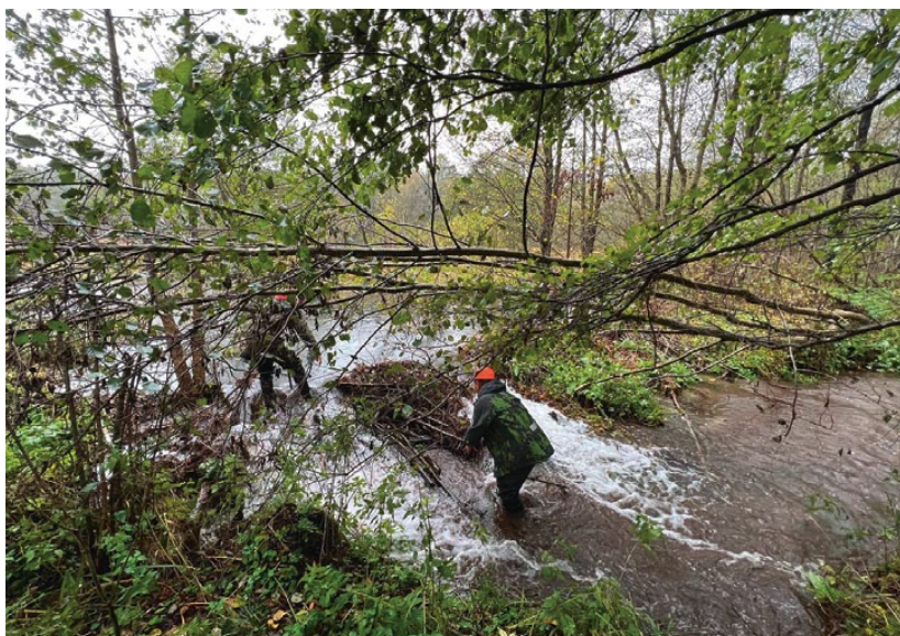
Removal of beaver dams in 2023 Beseitigung von Biberdämmen im Jahr 2023
