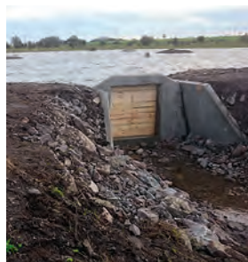
Baumaßnahme zur Schaffung von Feuchtgebieten
